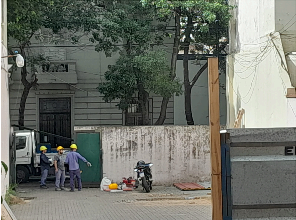
Inicio de las obras de la nueva sede del IIGG diciembre de 2023
