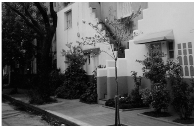
Imagen 1: 1937, Casa Colectiva Alvear II (CNCB) 128 viviendas.
